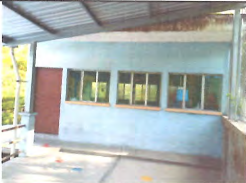
Foto 2: Preparación de la superficie y aplicación de pintura a dos manos, en paredes interiores y exteriores del establecimiento, módulo de aula, servicios sanitarios, bodega, columnas de barandal y muro.
