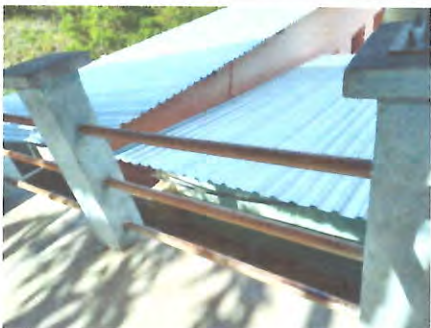
Foto 5: Reparación de barandales metálicos, incluyendo fijaciones, pintura y soldaduras.
