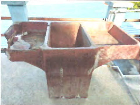
Foto 3: Sustitución pila, nivelada y con conexiones hidráulicas.
